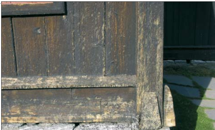
Foto 2. Püstpalkkiriku konstruktsioonis toetuvad nurgapostid alumistest vööpalkidest moodustuvale raamile, mis on vundamendi abil pinnasest kõrgemale tõstetud. Nii alumistes kui ülemistes vööpalkides on sooned seinaplankude otste fikseerimiseks.
