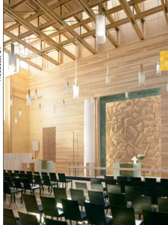
Foto 5. Väljastpoolt on Laajasalo kirik kaetud suuremas osas vaskplekiga, konstruktsioonis ja interjööris aga domineerib puit – “altarimaalgi” on haavapuu tükikestest valmistatud mosaiik.
