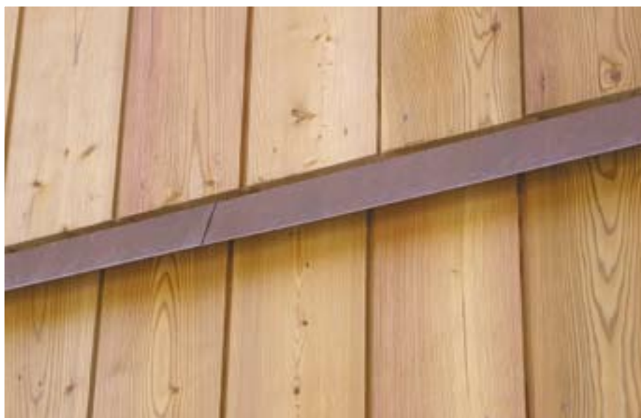
Foto 7. Lehisest vertikaalvooder, paraku on näha ka otsa lõhenemist naelutusel.
