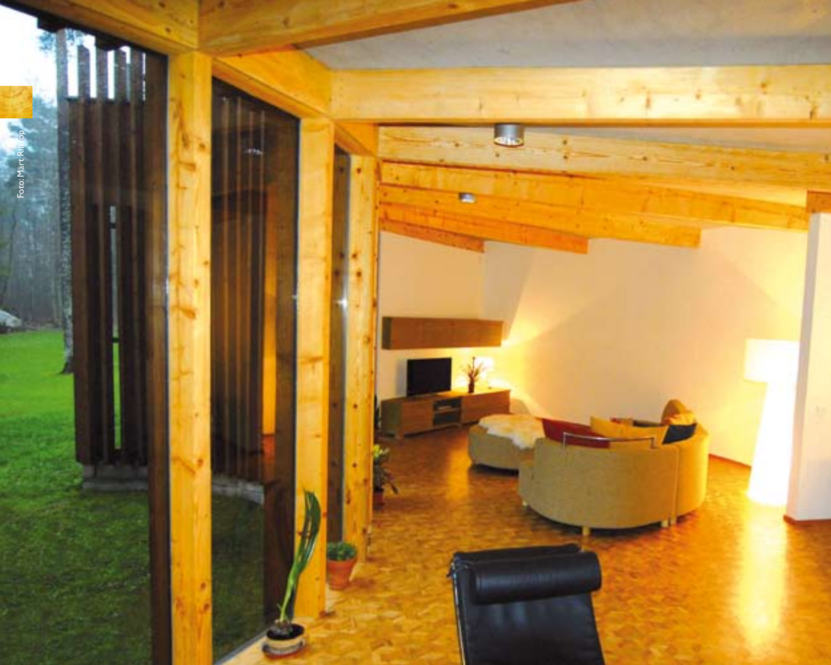
Foto 6. Laetalad paiknevad kujuteldava ringi raadiuse suunaliselt.
