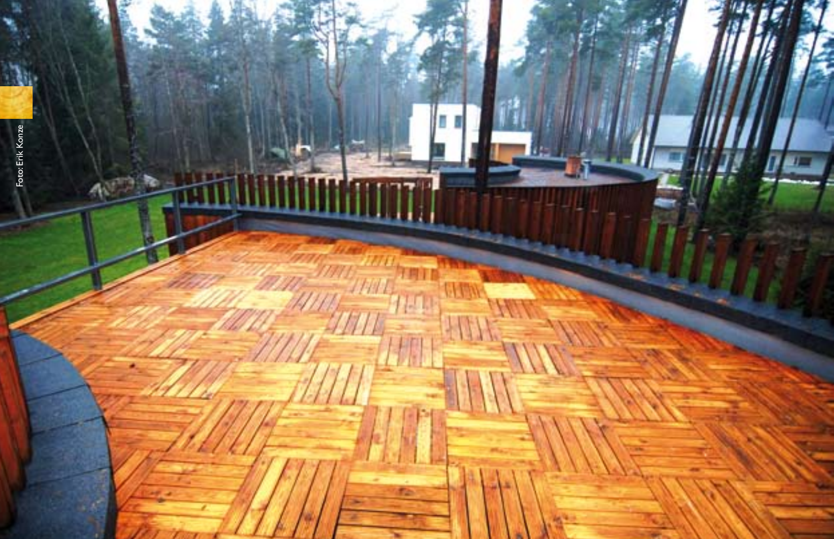
Foto 2. Osa eluploki teisest korrusest moodustab terrass, välisvoodris kasutatud prussid küünituvad terrassi piirdeks.
