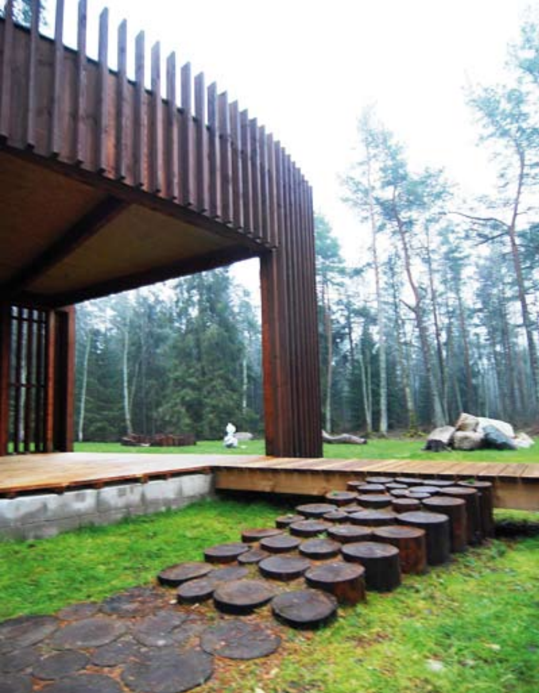
Foto 3. Maasse kaevatud puitpakud on nii sillutiseks kui laueks trepiks terrassile.
