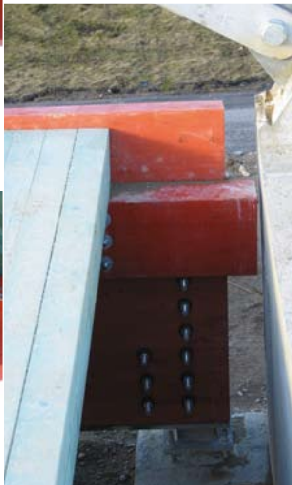
Foto 4. Silla käiguosa prussid toetuvad taladele kinnitatud konsolidele. Puitsilla puhul praktiliselt puudub vajadus pikisuunalise paisumise kompenseerimise vuukide järele.
