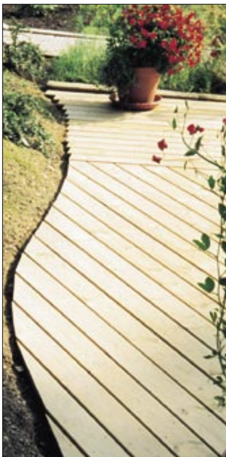
Foto 6. Lihtsa terrassi lauad naelutatakse otse aluspinnale toetuvatele tugiprussidele.
