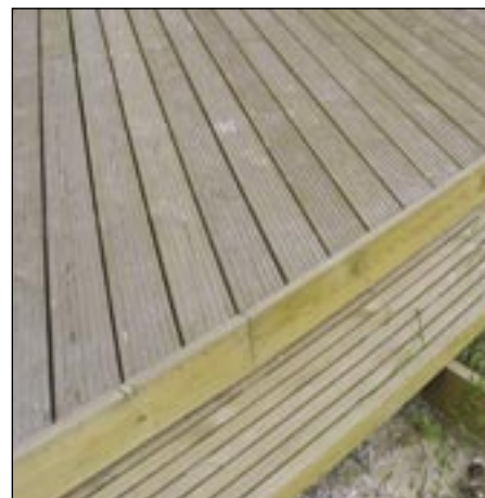
Foto 8. Soonitud pinnaga terrassilaud on vihmast märjana vähem libe, ehkki nii soontesse kui laudadevahelistesse 6...7 mm piludesse kipub prahti kogunema. Ohemaid laudu saab kinnitamisel ka painutada, nende vahe aitavad ühtlasena hoida sinna paigutatud distantssklotsikesed (näiteks vineerist).
