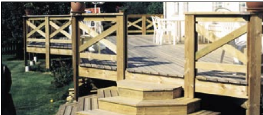
Foto 7. Keerukama konstruktsiooni korral tuleb tugipostid korralikult toetada, et vältida nende ebaühtlast vajumist pinnase külmumise-sulamise tõttu. Immutusvahendeid saab ka toonida, levinuim on pruunikas toon roheka asemel.
