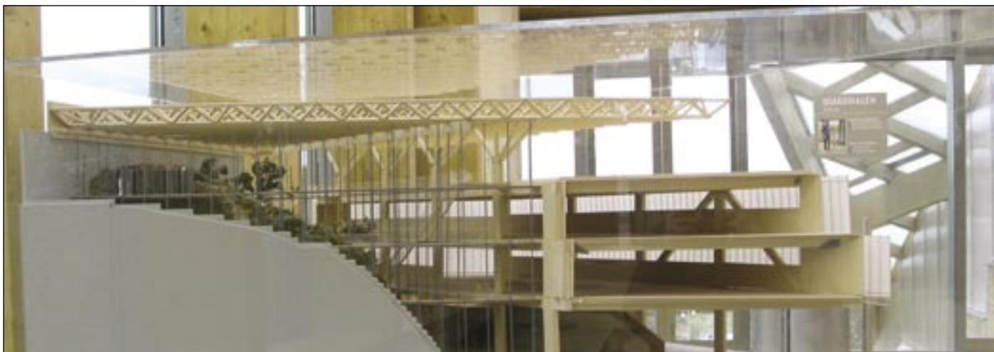
Foto 1. Universeumi vihmametsa sektsiooni (vasakul) ja liimpuidust postide tahukakujulise osa makett. Sõrestikfermidest katus ulatub 12-meetrise konsoolina liimpuidust tahuka katusel oleva terrassi kohale. Vihmametsa kohal on talade sille kuni 35 meetrit.
