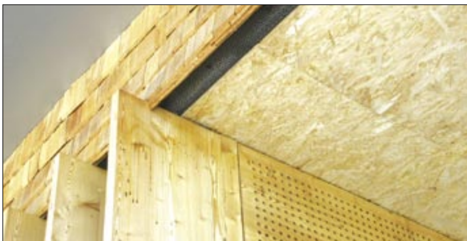
Foto 6. Ka astmete kohal saab tuulutusvahe avatuks jätta, tiheda võrgu kasutamine mujalgi sarnastes kohtades tuleb kasuks.
