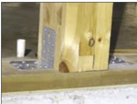
Foto 3. Eestis, kus termiite ei ole, vajab immutust vaid puitkarkassi alumine vööpruss.
