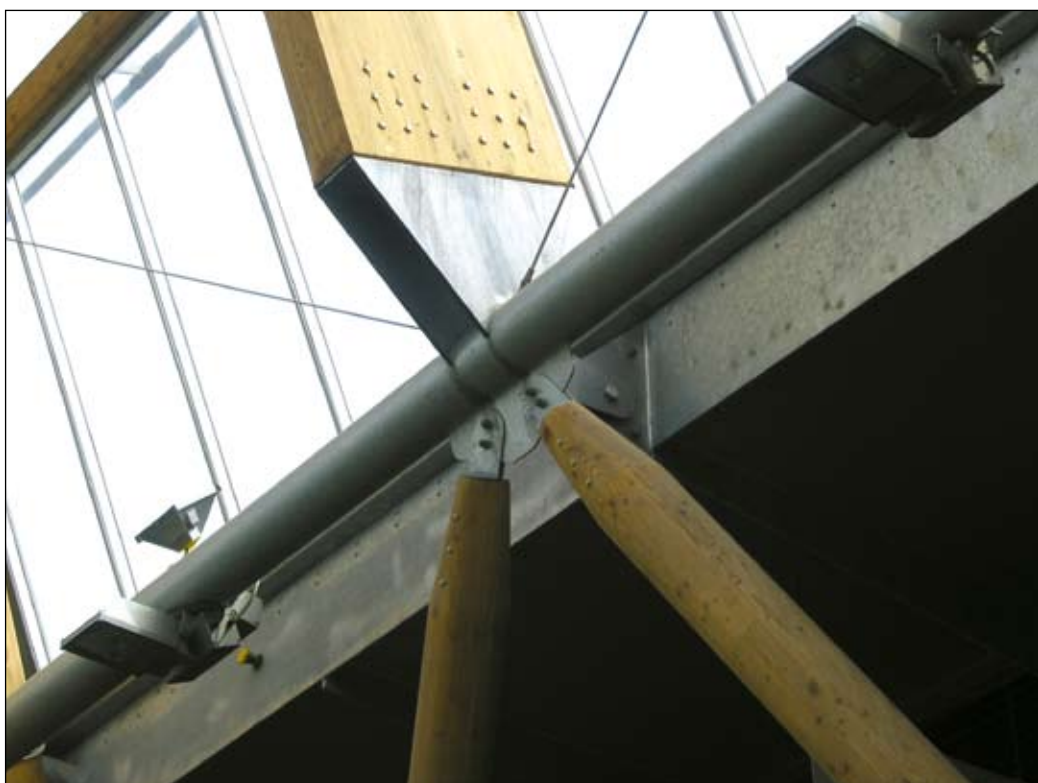
Foto 5. Liimpuidu liiteid, nii omavahelisi kui muu struktuuri külge, on üsna palju, silma hakkavad need siiski vaid lähemal vaatlusel.
