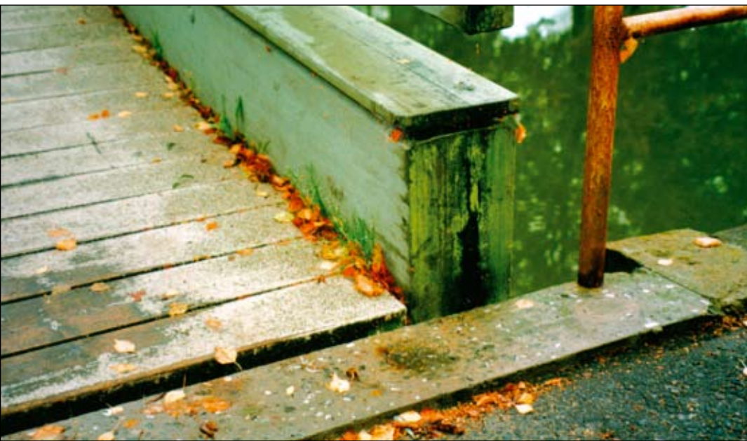
Näide halvasti lahendatud konstruktiivsest kaitsest: konstruktsioonile kogunev prahht takistab konstruktsiooni kuivamist ja loob kasvupinnase puidu mädanemiseks.
