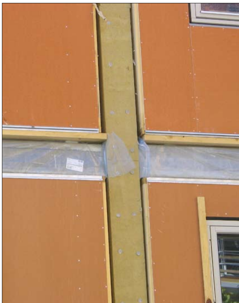
Foto 4. Tehases valmistatud puitkarkasspaneelid monteeritak- se betoonkarkassi «sahtlitesse».
