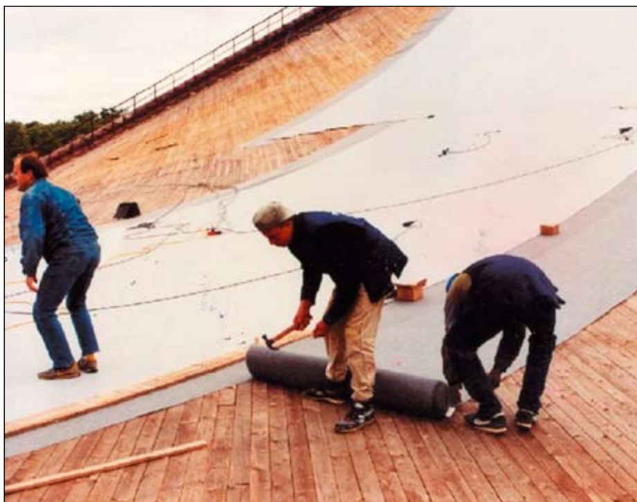
Joonis 14. Tartu laululava koorik(ripp)katuse katmine PVC-kattega.
