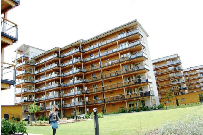
Foto 3 Växjösse ehitatud kaheksakordsete ristkiht liimpuidust majade elutsükli analüüs näitas, et majade jaoks puitosade tootmisel tekkivatest jäätmetest saab toota rohkem energiat kui ehitusprotsessis kulutatakse.
