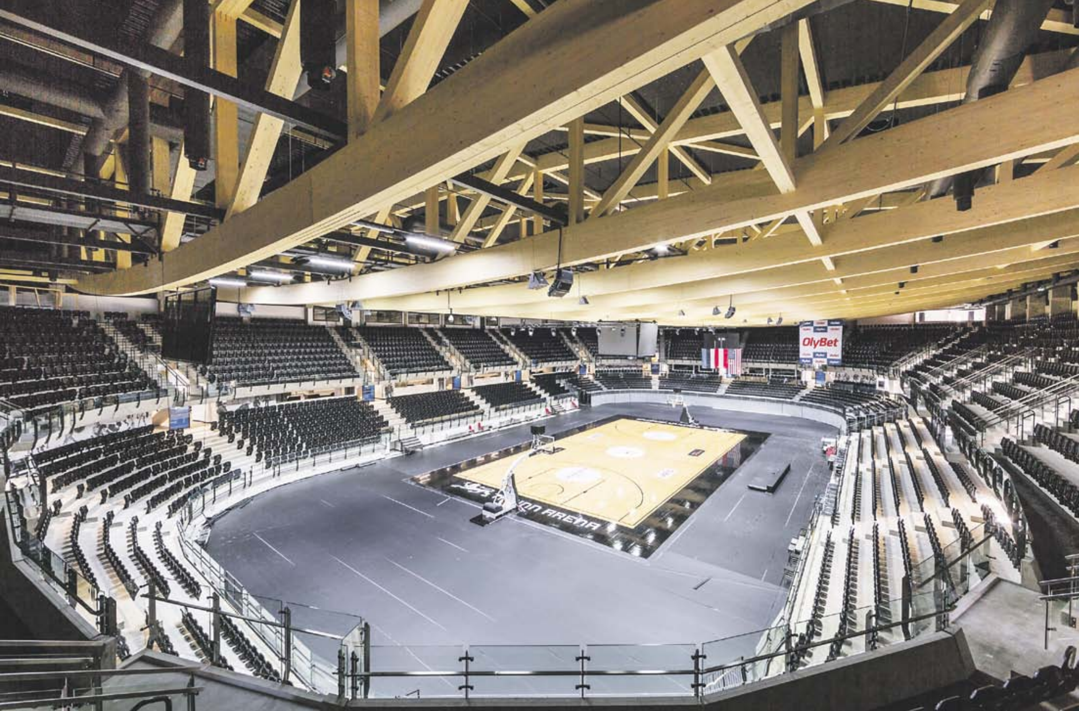
Tondiraba jäähalli liimpuidust fermid
